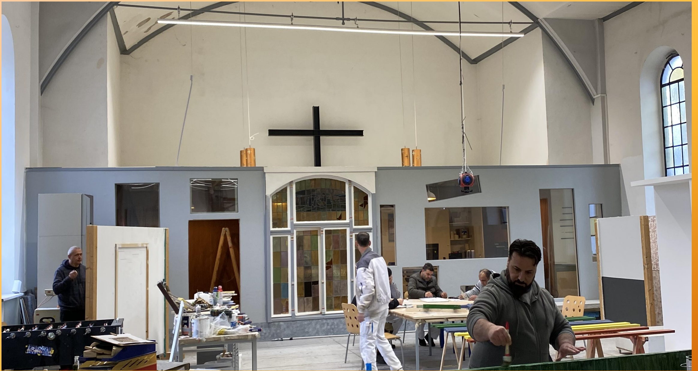
Beratungsstelle Arbeit, Werkkiste, ehem. ev. Kirche 26.4. 23
