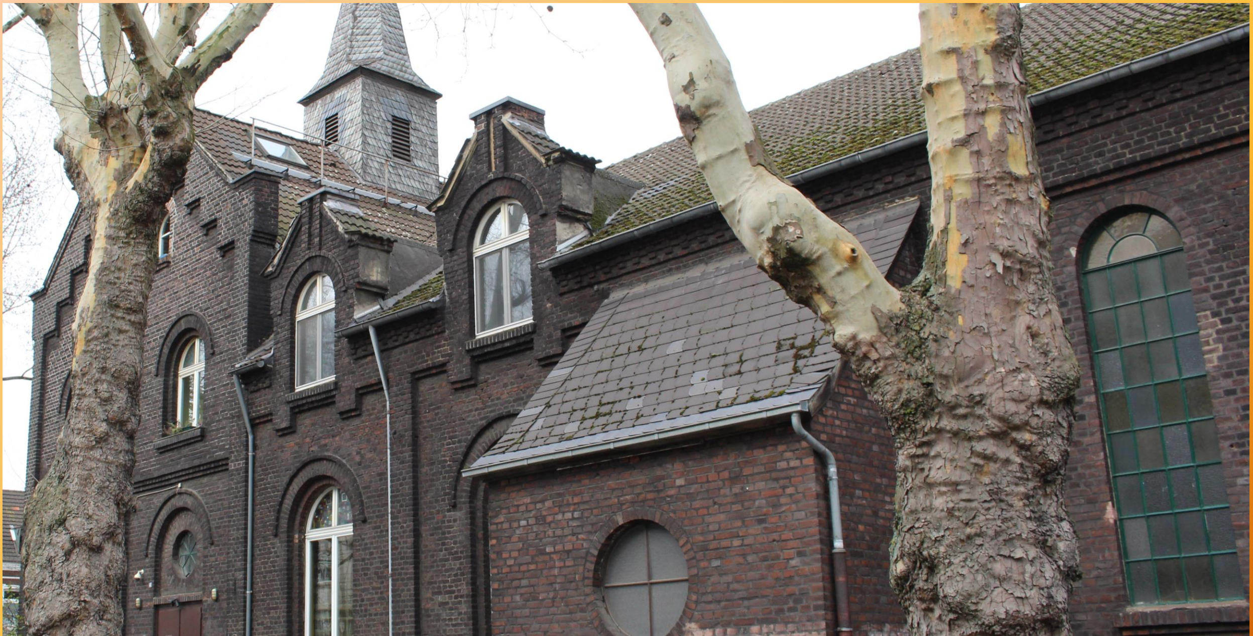
Ev. Pfarrkirche mit inkorporiertem Gemeindehaus von 1909, DU_Bruckhausen 12.3. 2019
